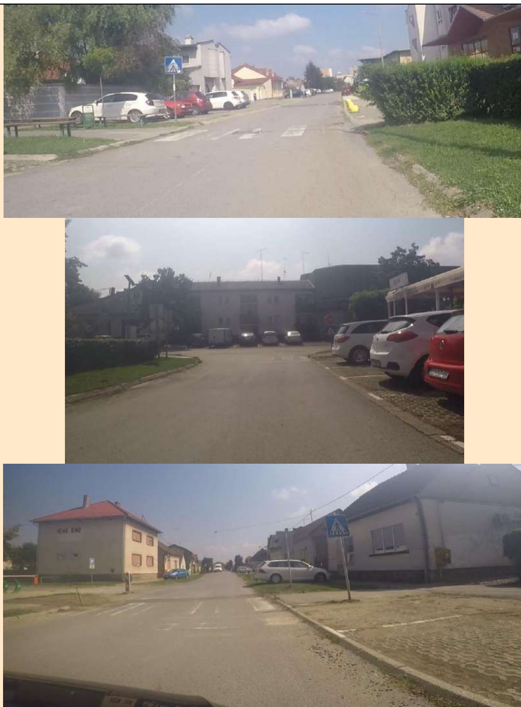
Slika 3. Smanjena preglednost na pješačkom prijelazu
